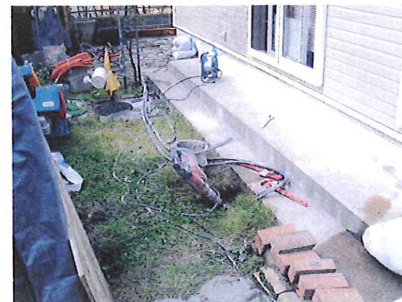
4-①.掘削・補強材注入
