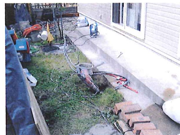
4-①.掘削・補強材注入
